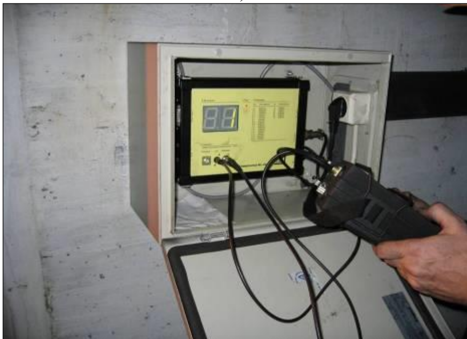
Рисунок 4 – Основные аппаратные блоки системы а) датчики вибрации, б) коммутирующий блок, в) блок связи
